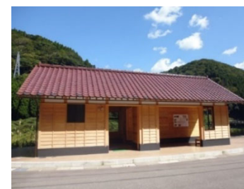
休憩所兼トイレの整備
