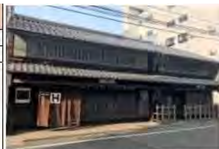
外観（右側が主屋北棟）
