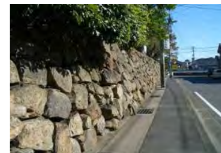
津山城宮川門跡石垣(津山市)
