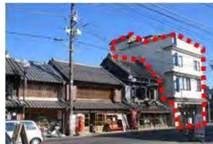
(例) まちなみの連続性が損なわれている様子
