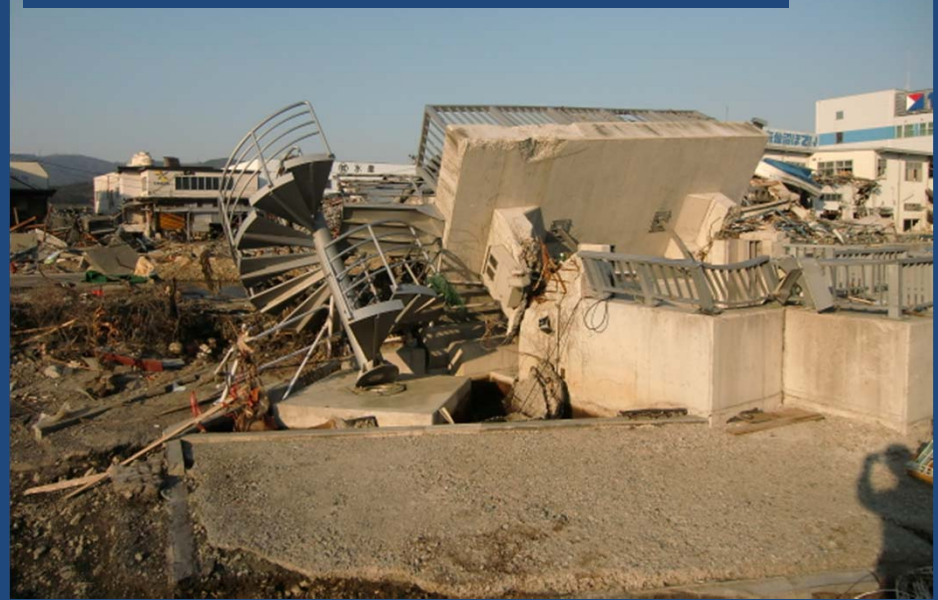
気仙沼：破壊された展望台
