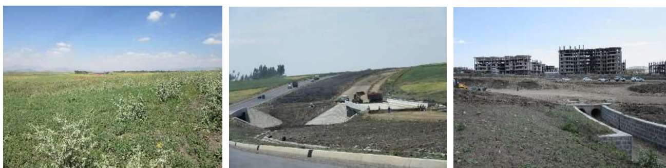
左から、キリント工業団地予定地の日本エリア候補地の現状、隣接する高速道路の工事、高速道路を挟んで日本エリアの向かいでの団地建設。
