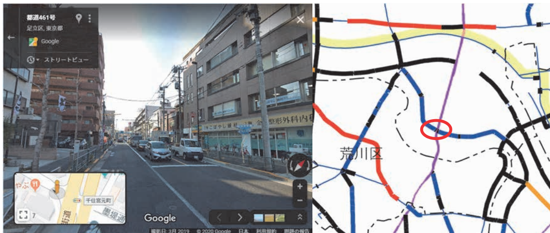
図 20 2019 年 3 月時点の足立区千住宮元町交差点付近の写真(左)と 同地点の無電柱化路線図(右)
