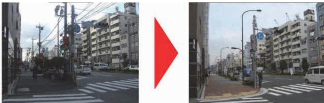
図 4 無電柱化前後（浅草通り・墨田区業平）（東京都 HP より 8 ）
