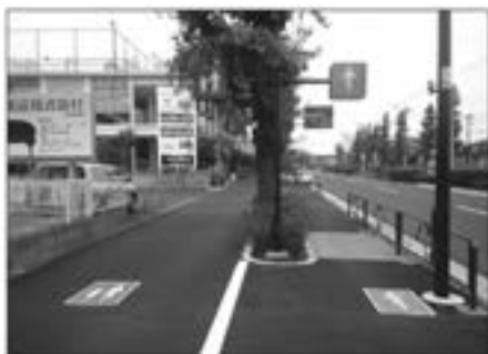
写真-3 自歩道の構造的分離(東八道路) 10
