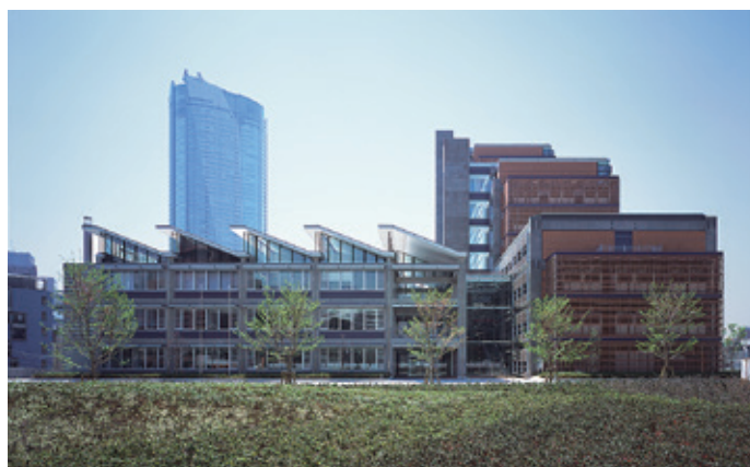
校舎：建物の設計は、山下設計とリチャード・ロジャースの設計共同体によるもの
