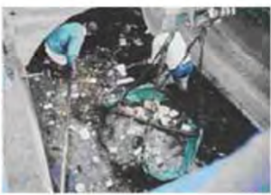
土地改良区職員による水路の清掃
