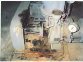
老朽化したポンプ
