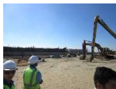
排水処理施設の建設現場
