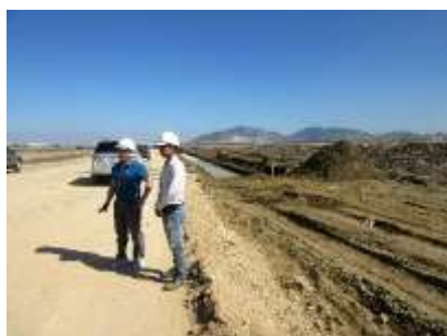
フーミー第3工業団地の土地造成
