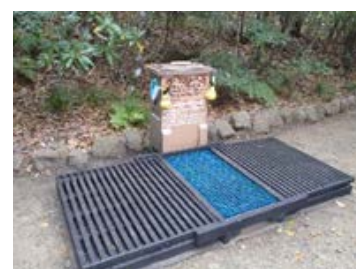
【写真6】 泥落としマットの設置
